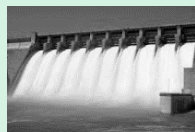
Geração Hidrelétrica Hídrica a fio d'água
