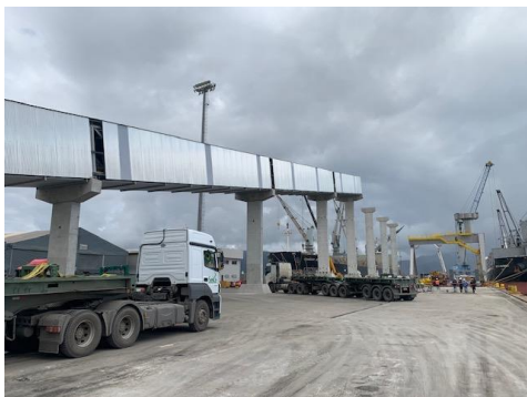
Pilares expedição (esteira que transportará grãos ao shiploader)
