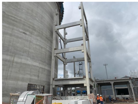
Torre dos elevadores de um dos silos de armazenamento
