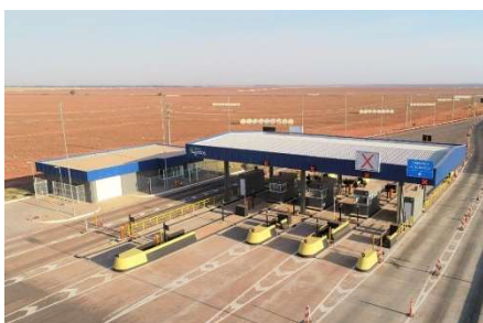
Praça P1 - Concluída
