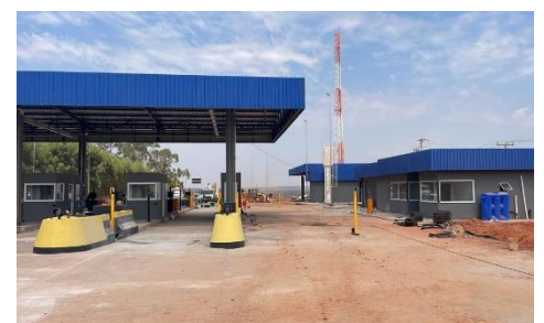
Praça P2 - Em conclusão
