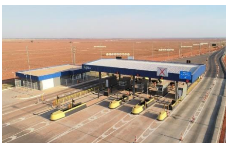
Praça P1 - Concluída
